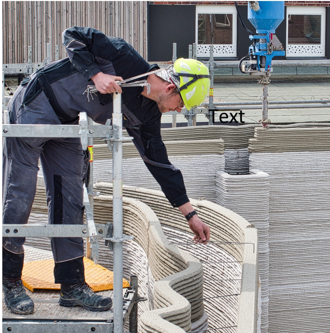
Filigrane Haken statt einem Stahlgeflecht stabilisieren die gedruckten Betonwände. FOTO: VÖLPEL
